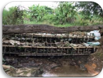
กิจกรรมสร้างฝายชะลอน้ำประเภทชั่วคราวในเขตปฏิรูปที่ดิน (ส.ป.ก.) จ.หนองบัวลำภู ครั้งที่ 1
