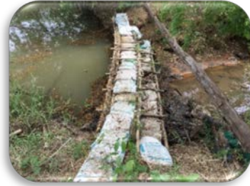
กิจกรรมสร้างฝายชะลอน้ำประเภทชั่วคราวในเขตปฏิรูปที่ดิน (ส.ป.ก.) จ.หนองบัวลำภู ครั้งที่ 1
