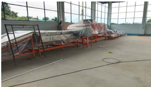
โรงเรือน พร้อมเครื่องแฉีกส้ม กลุ่มเกษตรกรทำไร่โป่งน้ำร้อน จังหวัดเชียงใหม่
