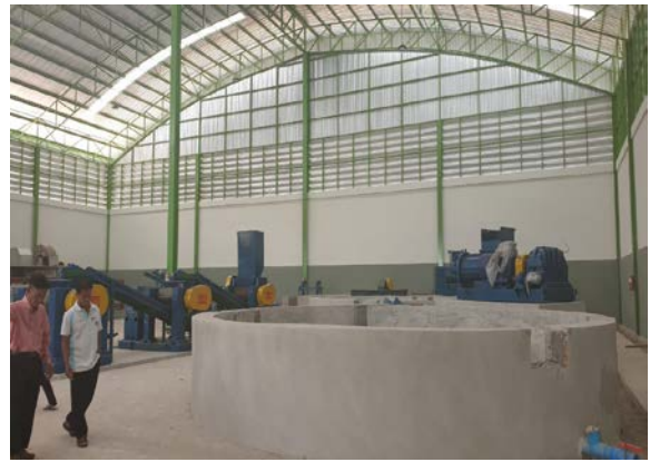
โรงคลุมเครื่องจักร (อยู่ระหว่างการติดตั้งอุปกรณ์) จ.ศรีสะเกษ
