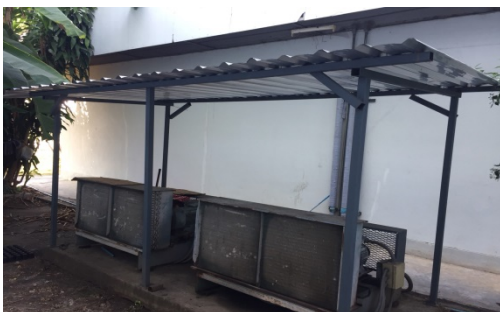
หลังคาคลุมมอเตอร์ไฟฟ้า
